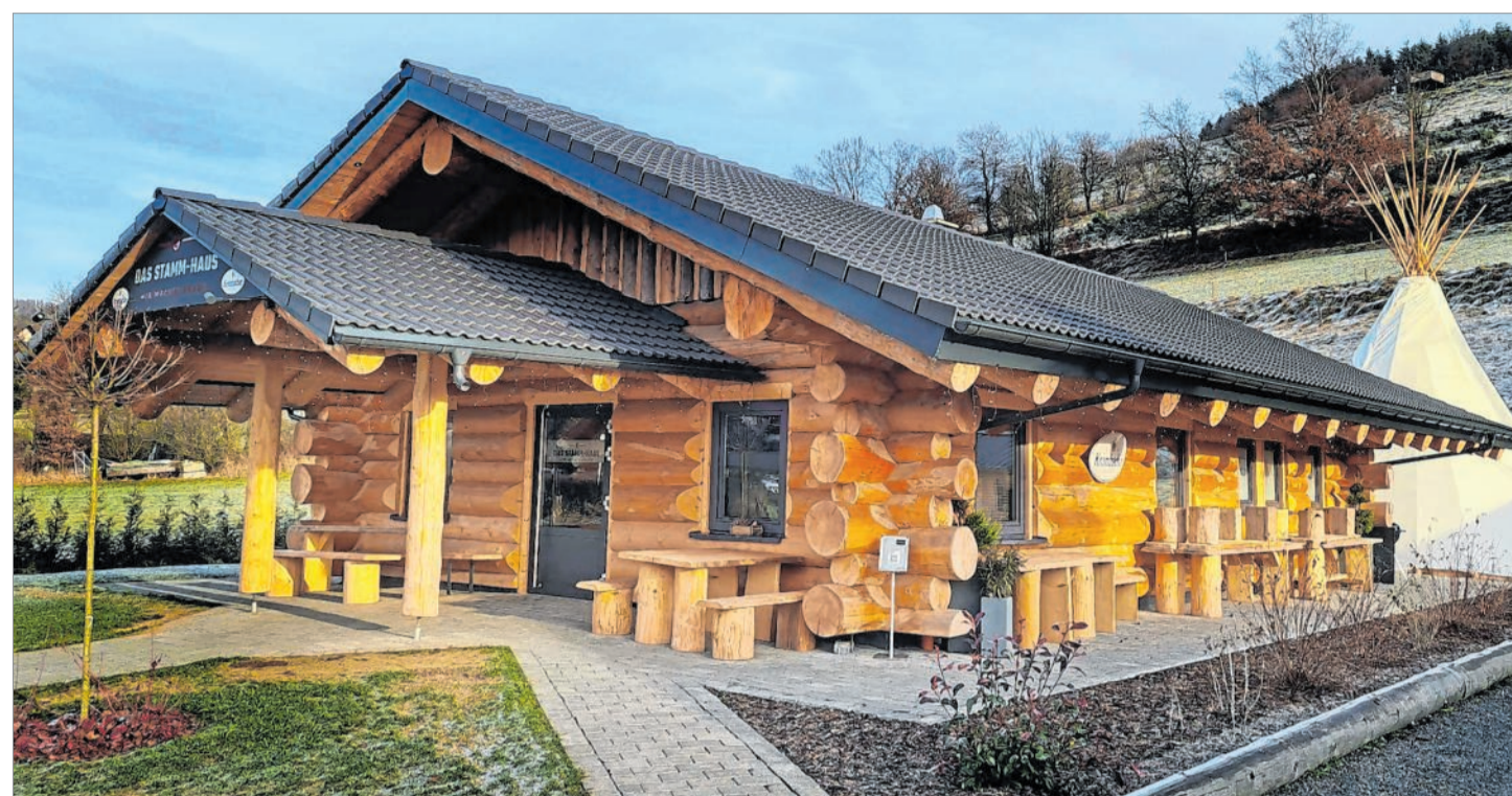
„Das Stammhaus“ im Bad Berleburger Stadtteil Wingshausen ist ein echter Hingucker. Die „Blockhaustypen“ haben das Gebäude aus Wittgensteiner Holz produziert.
